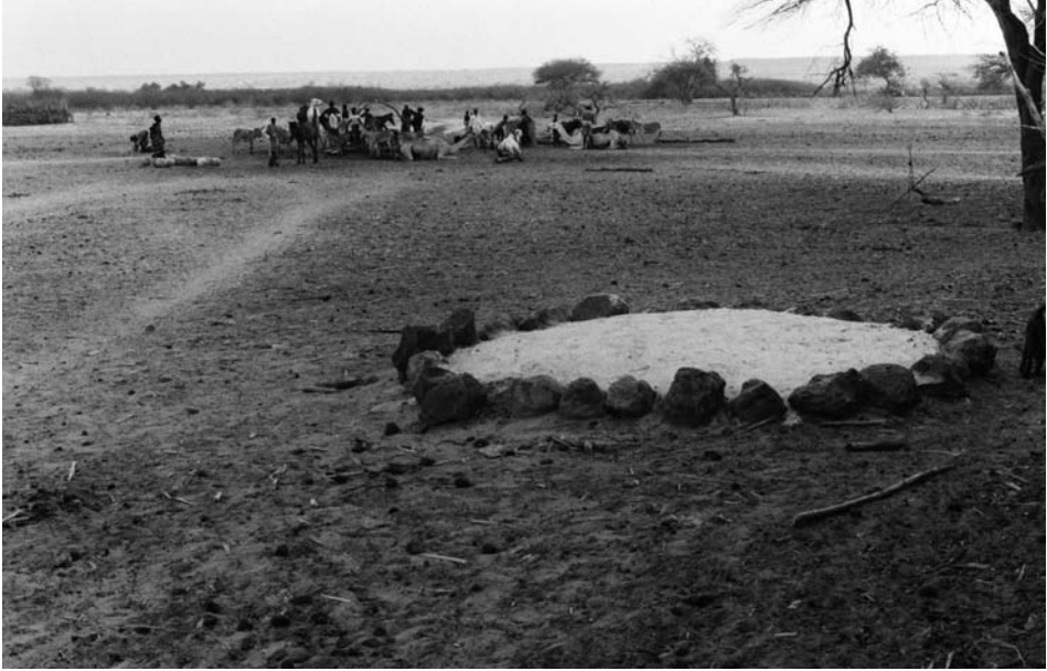
Première étape de la construction d'une case.
